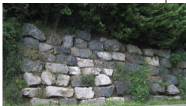
Enrochement sur la RD 65
